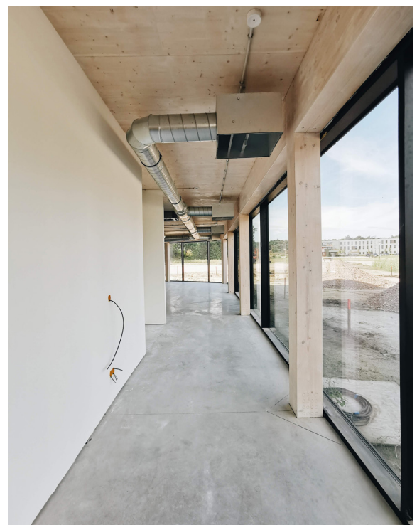
Zichtbare technieken, circulair opgebouwd CLT-draagstructuur is tevens de afwerking
